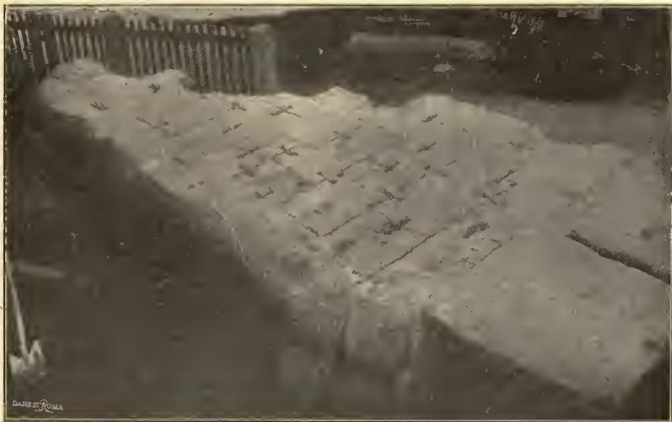
FIG. 5. — Terzo strato di blocchi in tufo.
