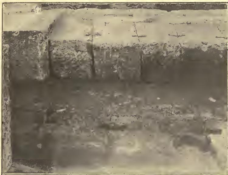
FIG. 7. — Sostruzione rinforzata da massi in tufo.
