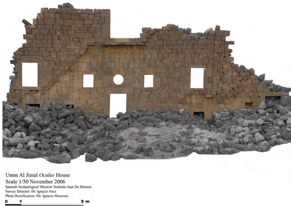
**Fig. 7** Umm al-Jimal. Complejo III (“Casa del Oculo”). Alzado ortorrectificado.
