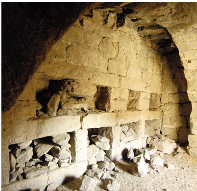
Fig. 3 Deir el Kahf. Vista del interior de una de las torres del quadriburgium tetrárquico con los pesebres para la caballería.
